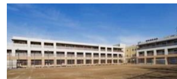
学校を改修して整備した住宅
